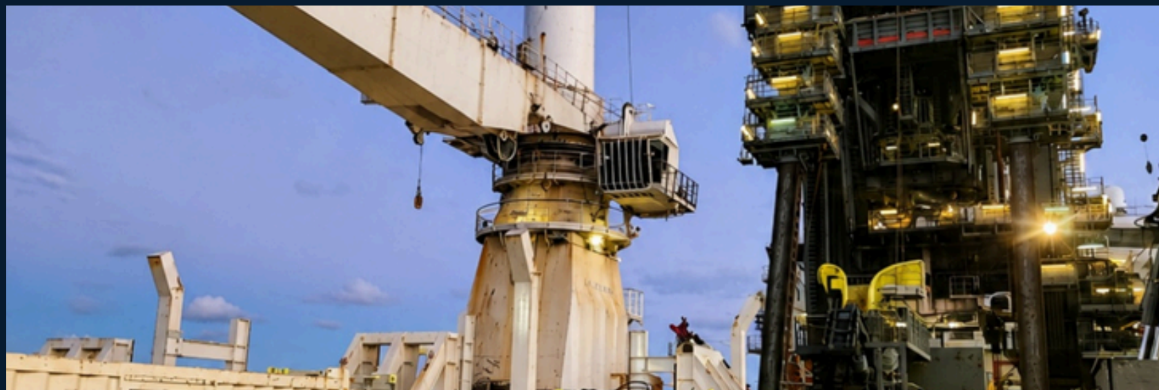
Troca dos rolamentos do Traction Winch de 400mt
