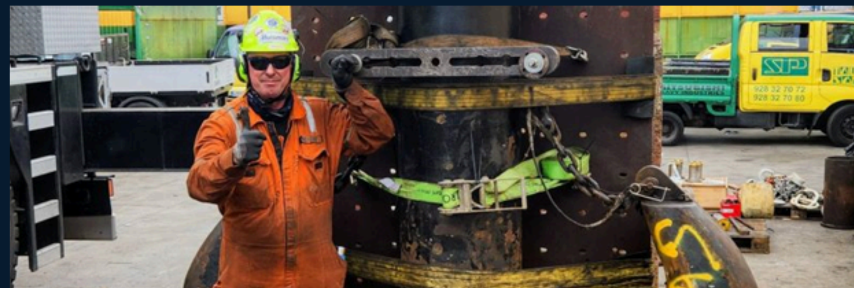
Reforma do Bloco auxiliar do Guindaste OMC de 5000mt
