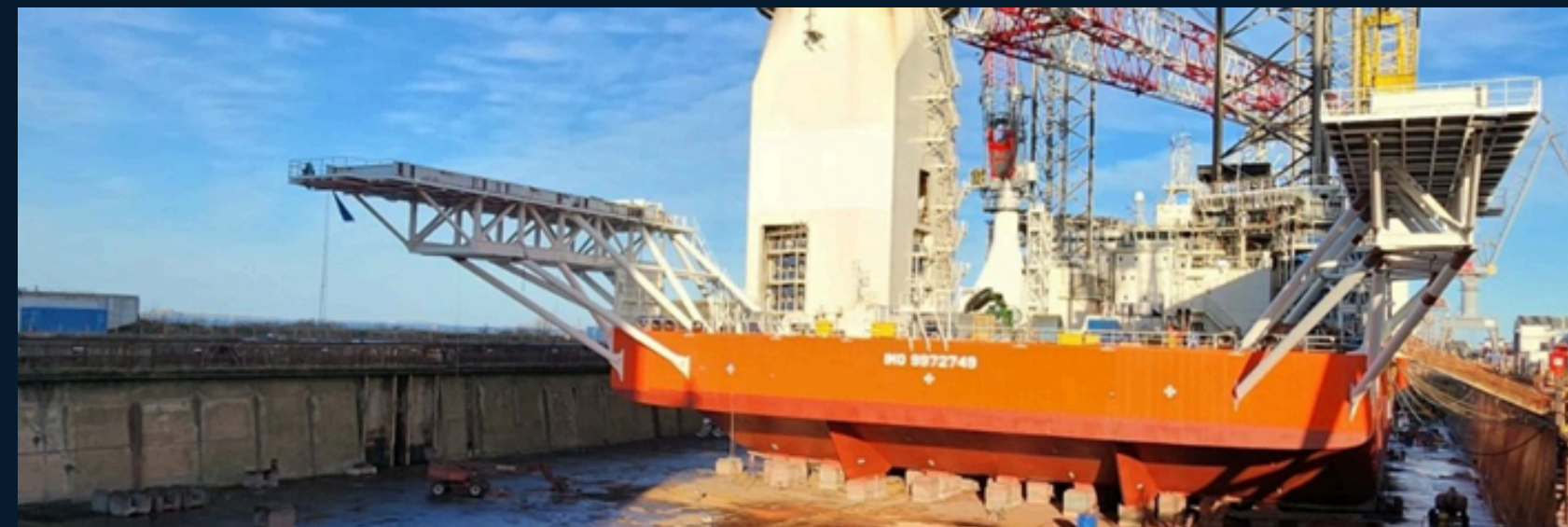
Troca de Gearbox do Guincho principal do guindaste de 2200mt
